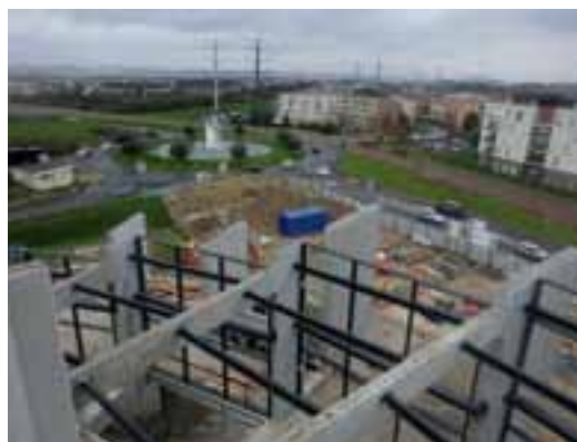
Mettre à l'abri un patrimoine immobilier, voire construire en propre au service de notre mission, comme ici avec le projet Martin Luther King à Créteil.
